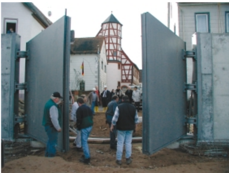
Technischer Hochwasserschutz ist in besiedelten Bereichen unverzichtbar:
